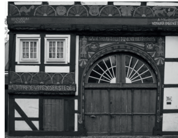
Der weitgehend unveränderte Fassadenteil mit dem erneuerten Tor, das seit den 1920er Jahren Oberlichter aufweist
